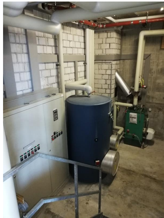
scaldament d'ieli existent
