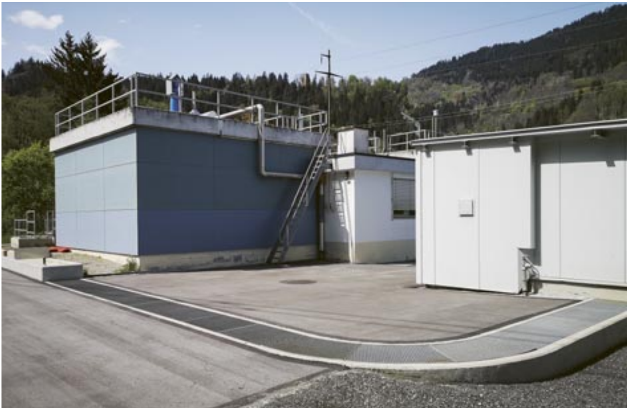
Planmässig schreitet die Sanierung der ARA Rueun voran und soll 2024 fertiggestellt sein.
