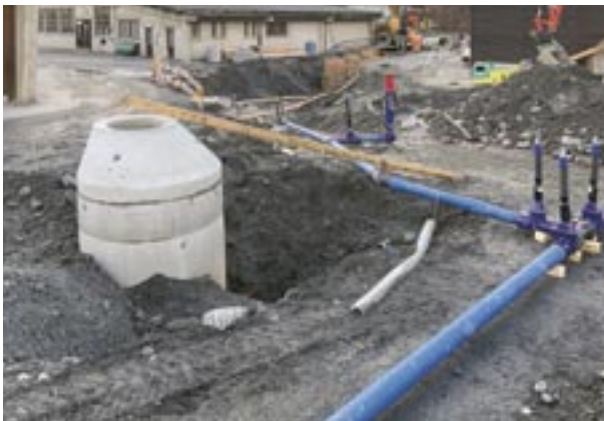
Die Bauarbeiten für den neuen Postautoplatz sind im vollen Gange.
