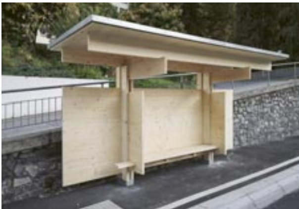
Das neue Buswartehäuschen beim Spital Ilanz.
