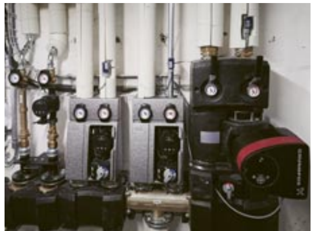
Die Elemente der Warmwasserinstallation sind ersetzt.
