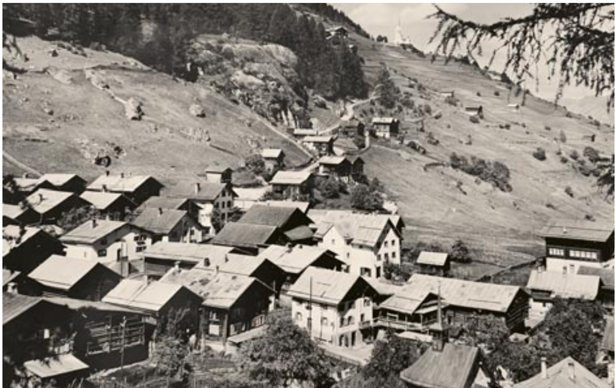
Ruschein, wo sich die Haus- und Stalldächer aneinander schmiegen. Im Hintergrund rechts oben die Kirche von Ladir.
